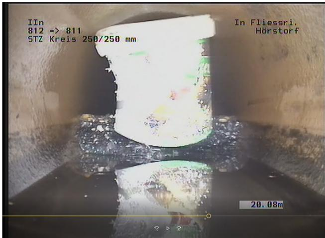
➔ Kübel, der vermutlich zur Verhinderung eines Rückstaus eingebracht wurde und nicht mehr entfernt wurde.
